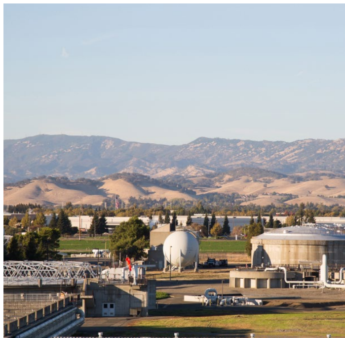
Sur la photo : centre de valorisation des déchets organiques Fairfield
