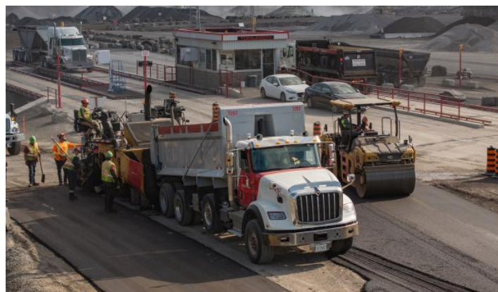
Sur la photo : étallement d'un mélange d'asphalte à faible intensité carbone
