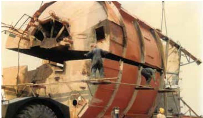
PHOTOGRAPHIÉ CI-DESSUS: Grande tour coupée en deux pour être transférée de Bourget à la nouvelle usine Ready Mix de Cumberland
