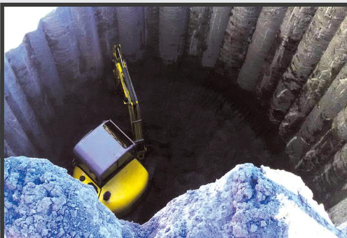
L'excavation au fond du puits du mur sécant circulaire en béton, qui a été creusé à l'aide d'une mini-pelle. Les bennes sont remplies, puis soulevées par des grues.
