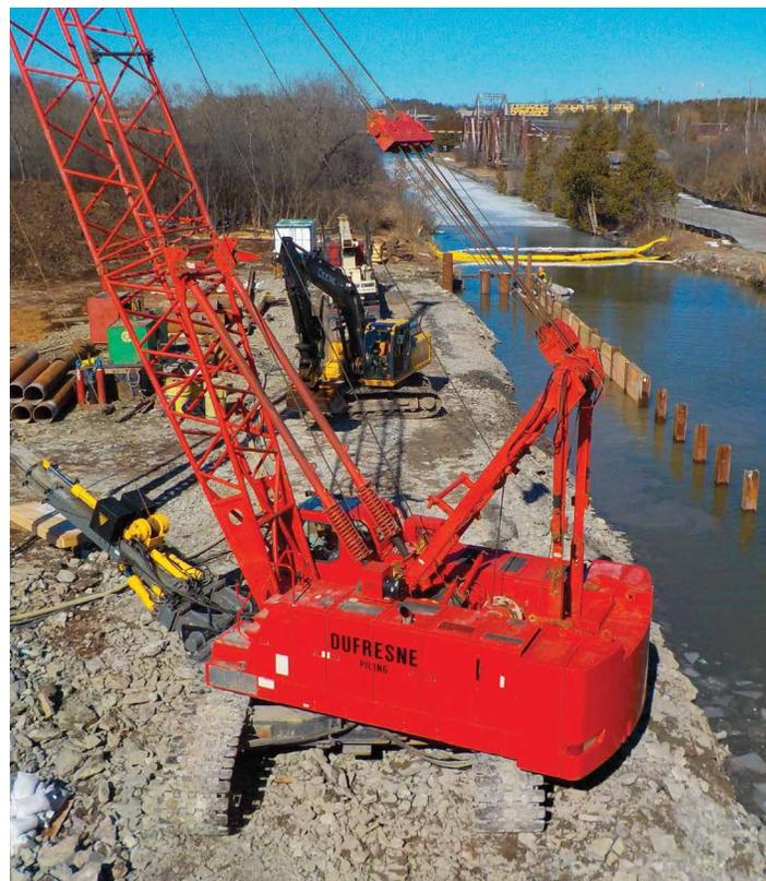
Dufresne Piling installe les pieux verticaux pour l'étape 1 du batardeau à l'aide d'une grue sur chenilles Manitowoc de 80 tonnes équipée d'un marteau-perforateur de fond de trou.
